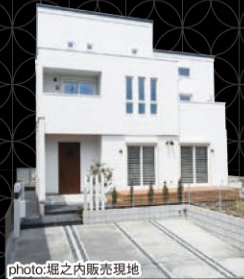
photo:堀之内販売現地
